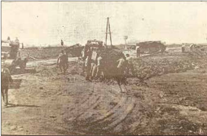
Aufschüttung des Geländes am Bootshaus mit dem ausgehobenen Boden
