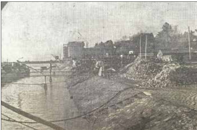
Zuckerrüben-Verladung am Hafen – im Hintergrund der begonnene Rohbau des Getreide-Silos Mitte November 1939
